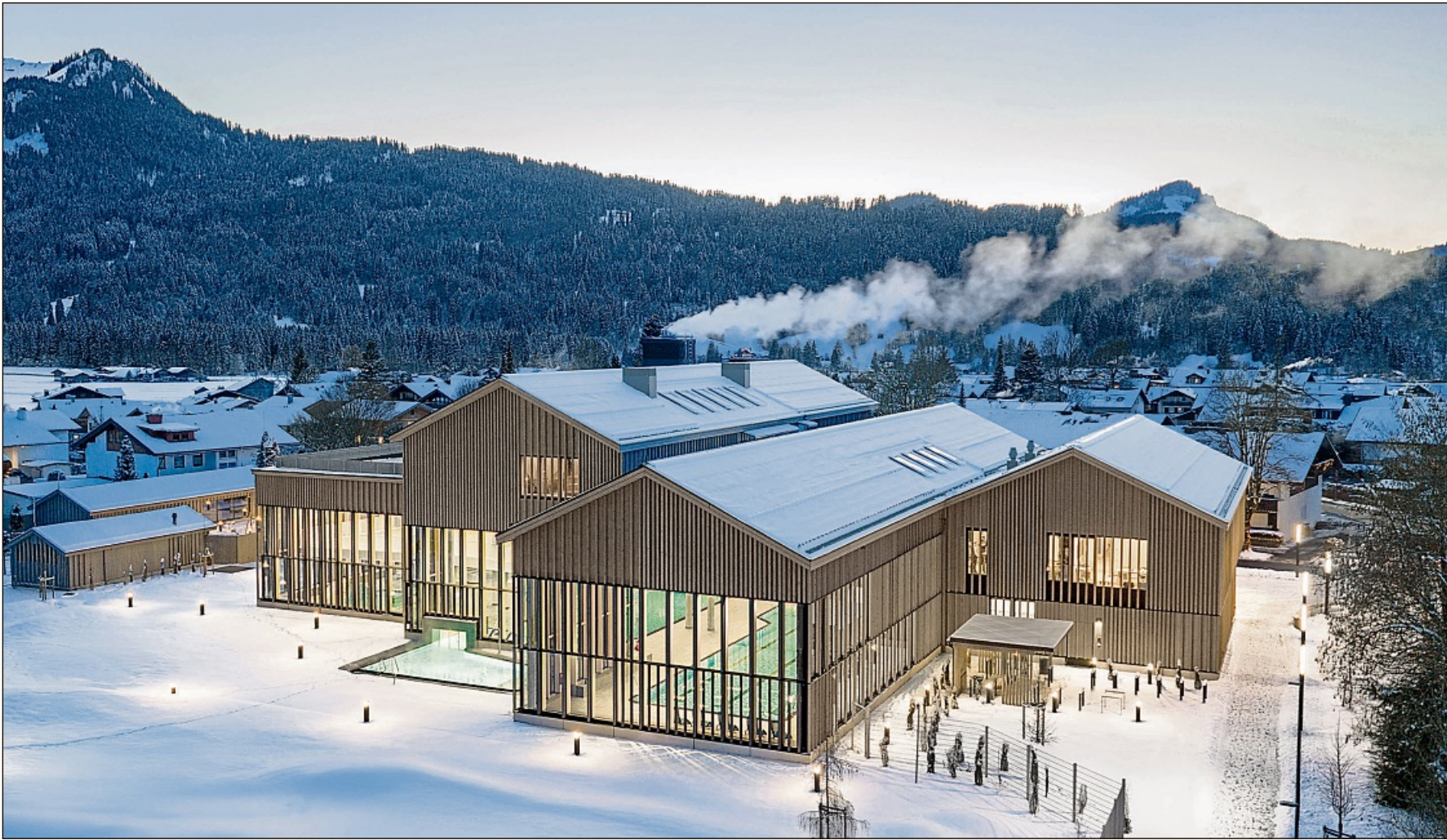
Die Therme liegt im südlichen Teil von Oberstdorf und bildet den Abschluss eines Ensembles.
